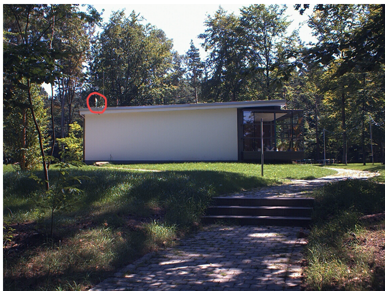
Abbildung G.10: Westseite von Gebäude 7
