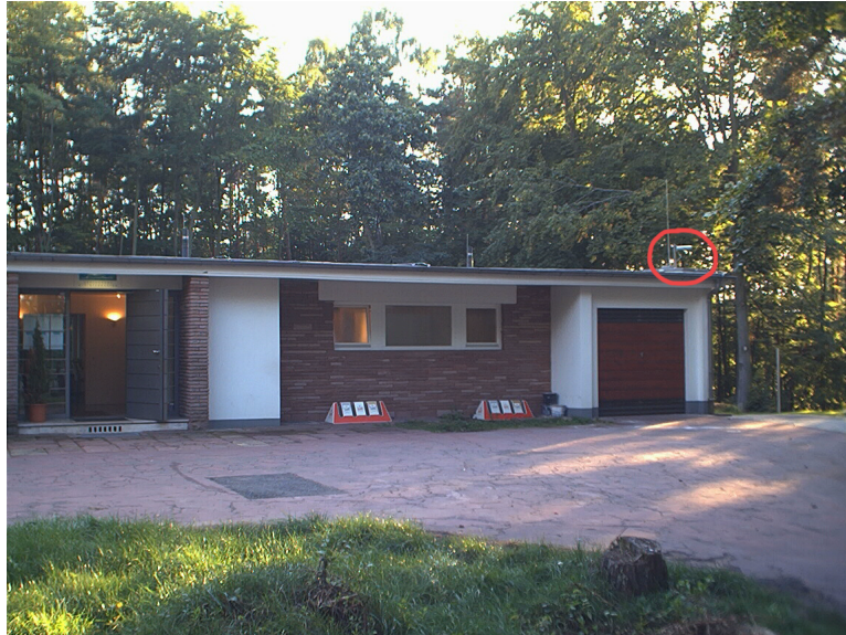
Abbildung G.11: Nordseite von Gebäude 7
